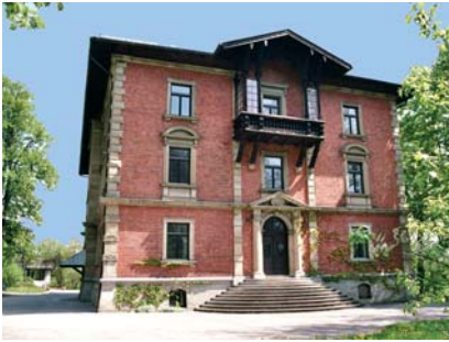
Frauenschule, BBZ, Südfassade
